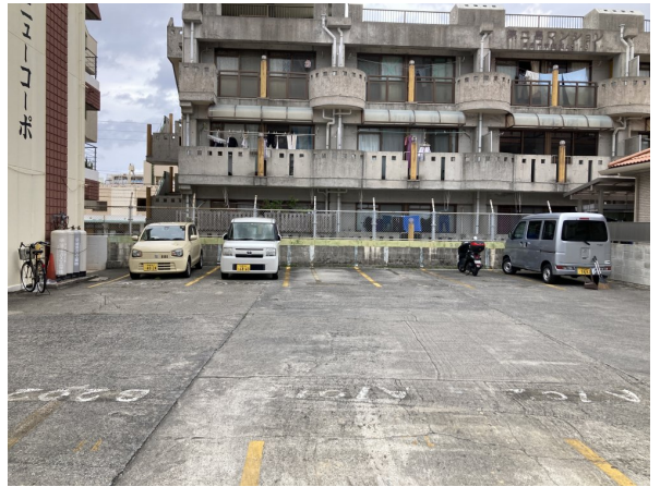
1. 駐車場・駐輪場
