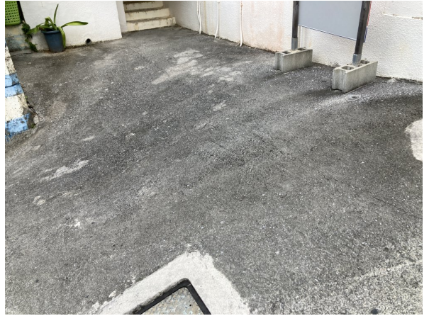
1. 駐車場・駐輪場
