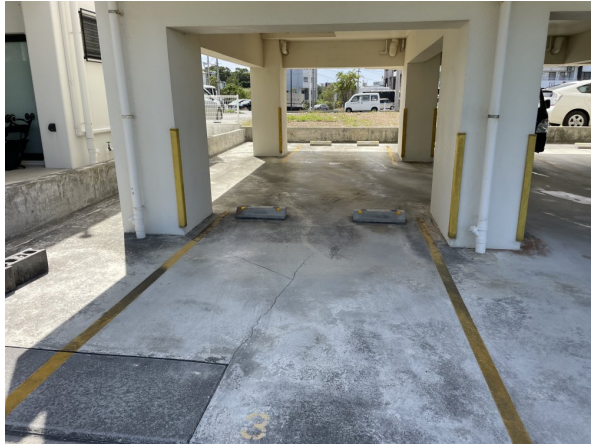
1. 駐車場・駐輪場
