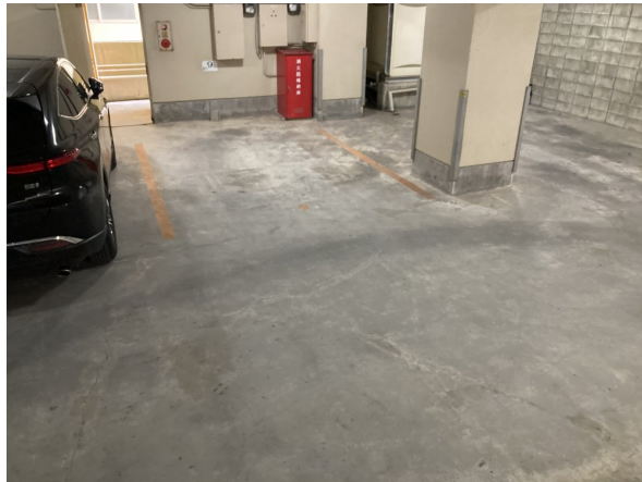
1. 駐車場・駐輪場
