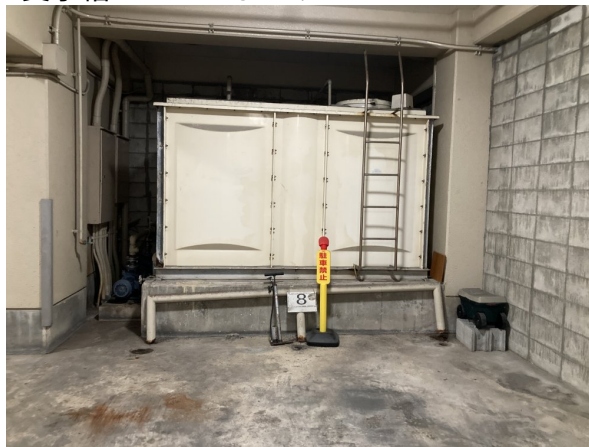
2. 受水槽フェンスまわり
