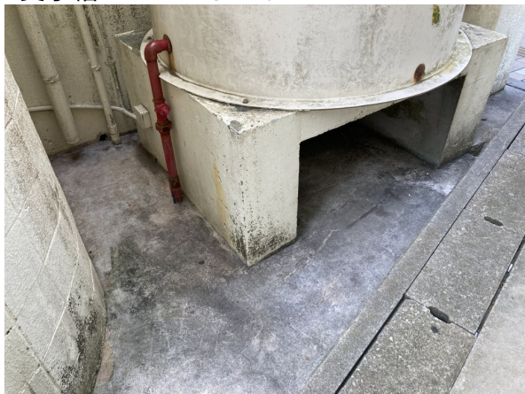
2. 受水槽フェンスまわり
