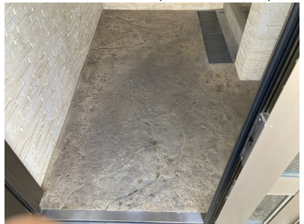
3.エントランスホール（タイル・ガラス）
