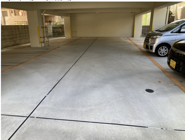
1. 駐車場・駐輪場
