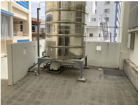
2. 受水槽フェンスまわり
