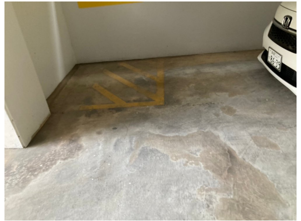
1. 駐車場・駐輪場
