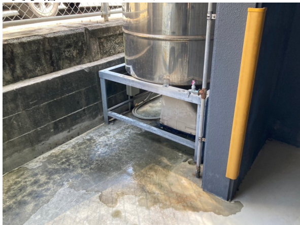
2.受水槽フェンスまわり
