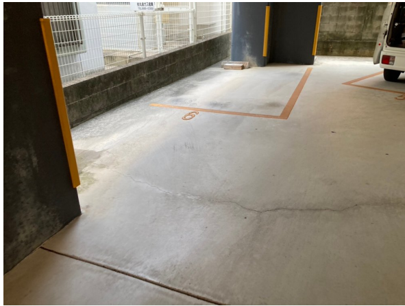
1. 駐車場・駐輪場
