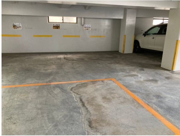
1. 駐車場・駐輪場
