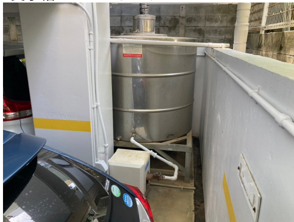
2.受水槽フェンスまわり
