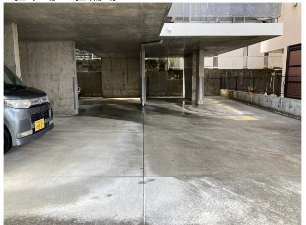
5.駐車場・駐輪場
