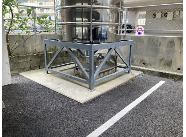
2. 受水槽フェンスまわり
