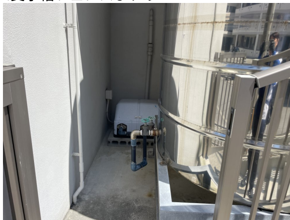
2. 受水槽フェンスまわり
