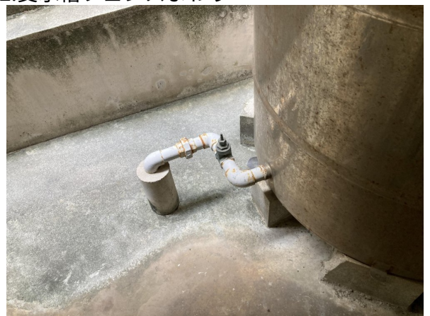
2. 受水槽フェンスまわり
