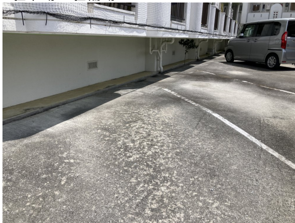
1. 駐車場・駐輪場
