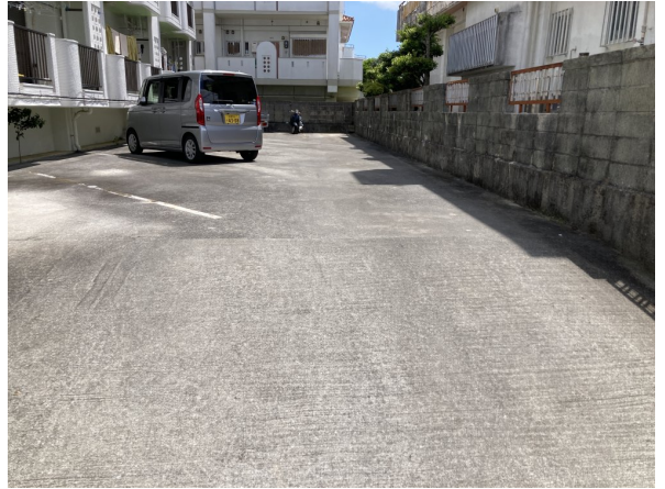
1. 駐車場・駐輪場
