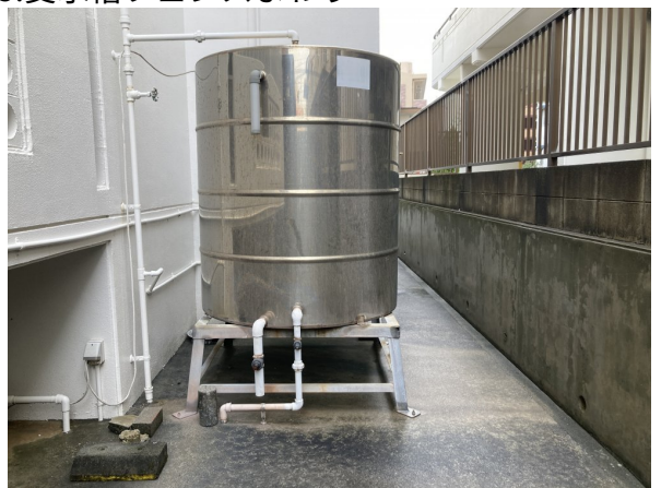
5.受水槽フェンスまわり
