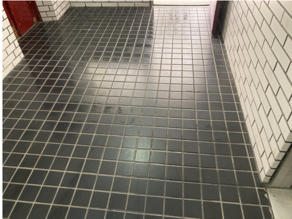
4.エントランスホール（タイル・ガラス）
