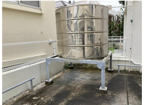
2. 受水槽フェンスまわり
