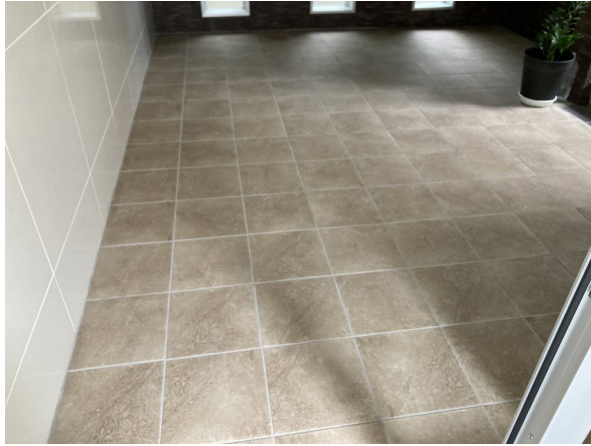
4.EV・ホール
