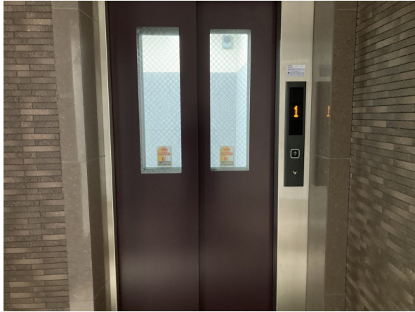
4.EV・ホール
