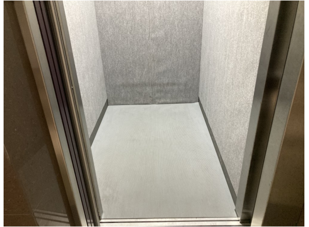
4.EV・ホール
