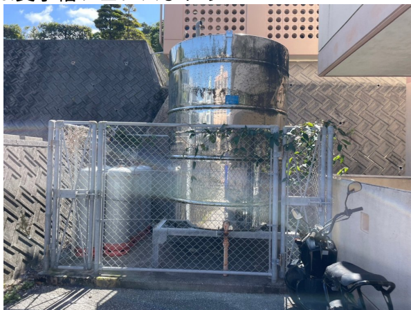
6.受水槽フェンスまわり
