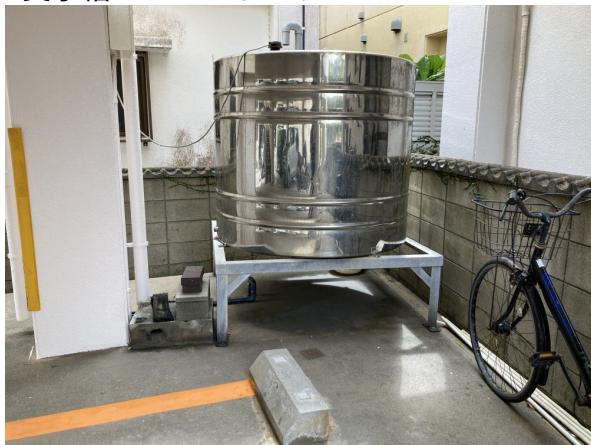
2. 受水槽フェンスまわり
