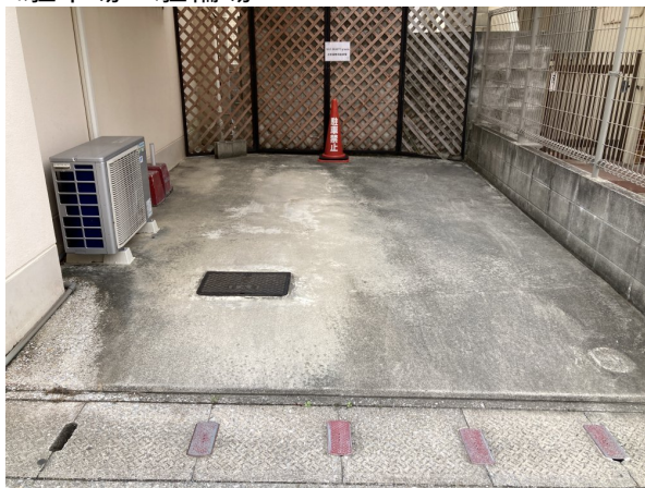
1. 駐車場・駐輪場
