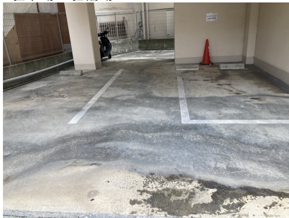
1. 駐車場・駐輪場
