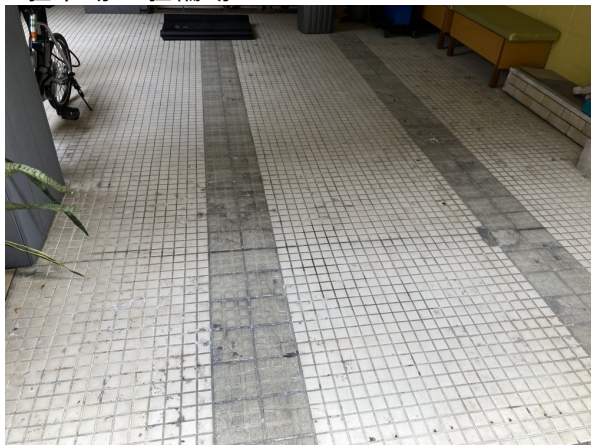
1. 駐車場・駐輪場
