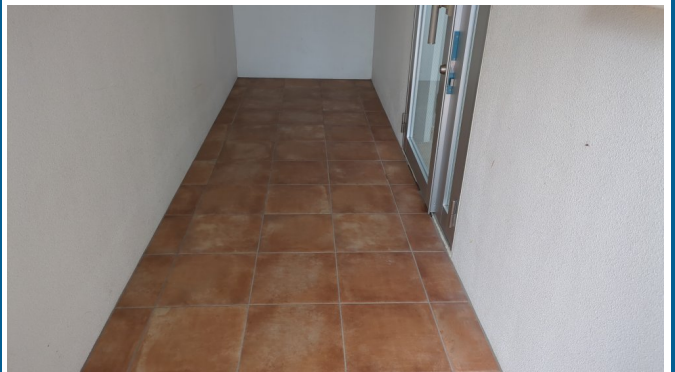
4. エントランスホール（タイル・ガラス）
