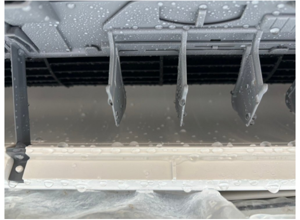
12.エアコンクリーニング
