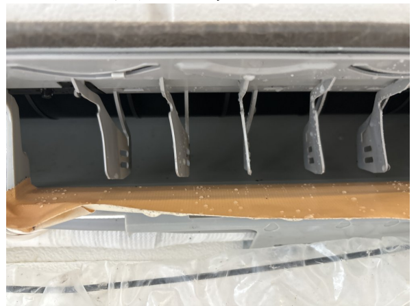
17.エアコンクリーニング
