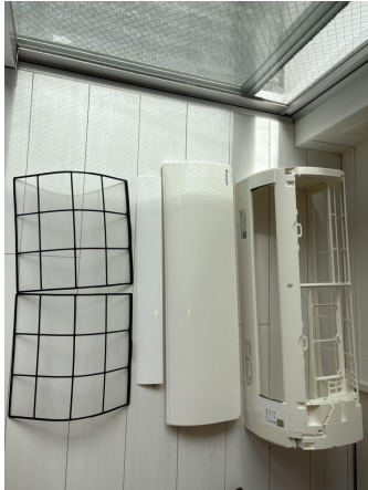
17.エアコンクリーニング
