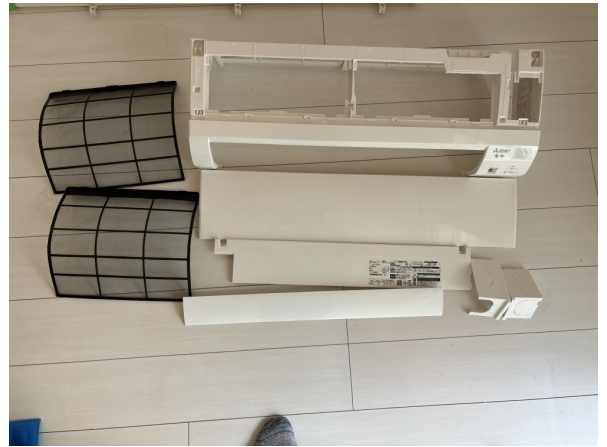
17.エアコンクリーニング
