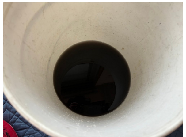
14.エアコンクリーニング
