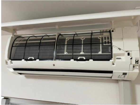
14.エアコンクリーニング
