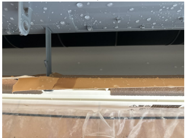
13.エアコンクリーニング
