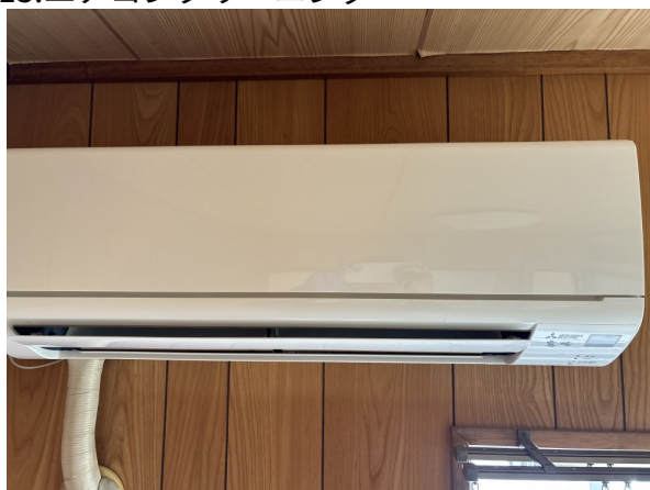
13.エアコンクリーニング
