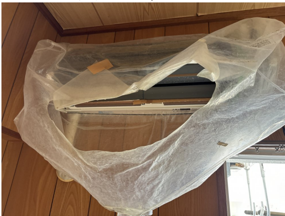
13.エアコンクリーニング
