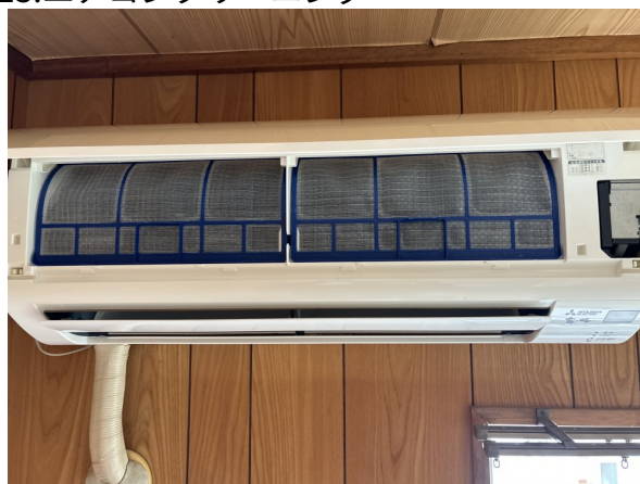
13.エアコンクリーニング
