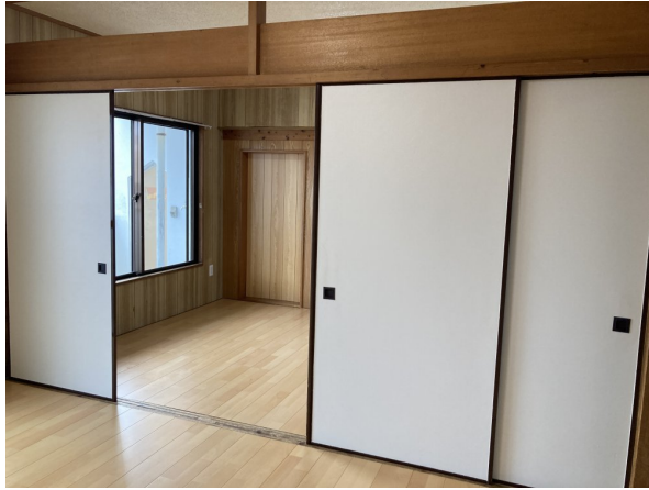
襖補修・調整済み
