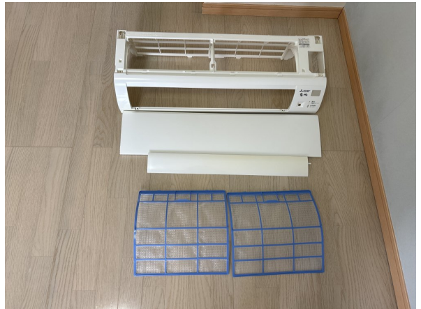
12.エアコンクリーニング
