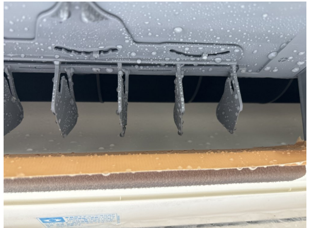
12.エアコンクリーニング
