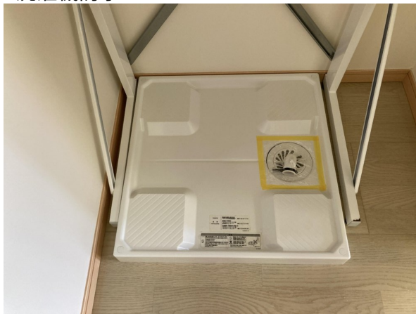
6.洗濯機防水パン
