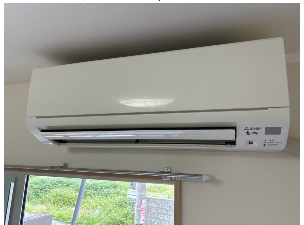
12.エアコンクリーニング
