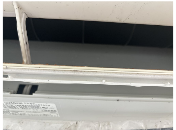
14.エアコンクリーニング
