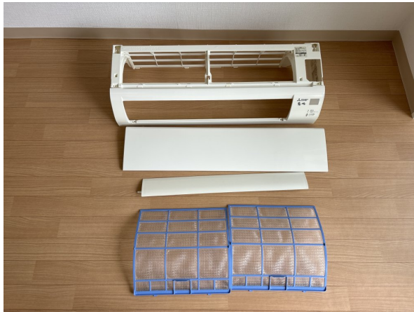
13.エアコンクリーニング
