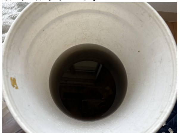
13.エアコンクリーニング
