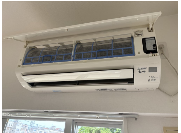
13.エアコンクリーニング
