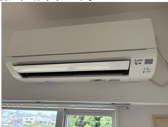
13.エアコンクリーニング
