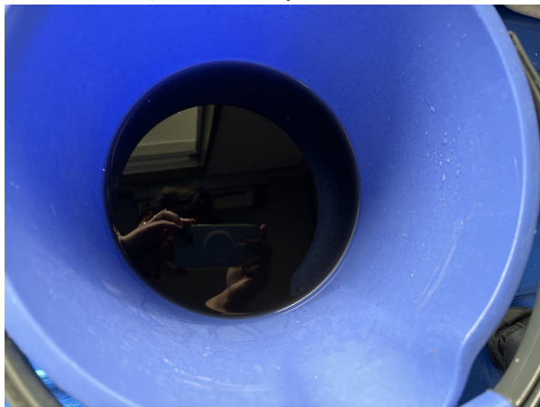
14.エアコンクリーニング
