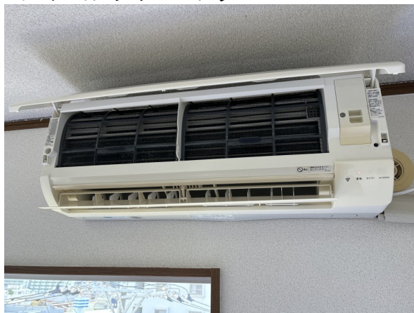
14.エアコンクリーニング
