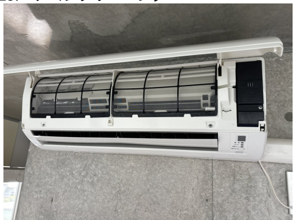
15.エアコンクリーニング
