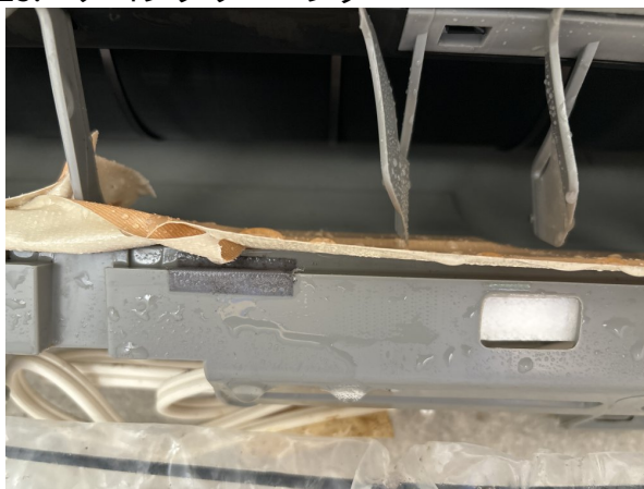
15.エアコンクリーニング
