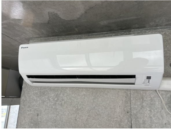
15.エアコンクリーニング
