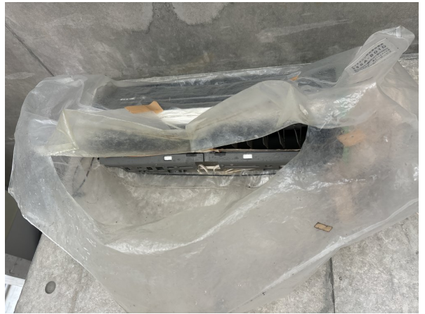
15.エアコンクリーニング
