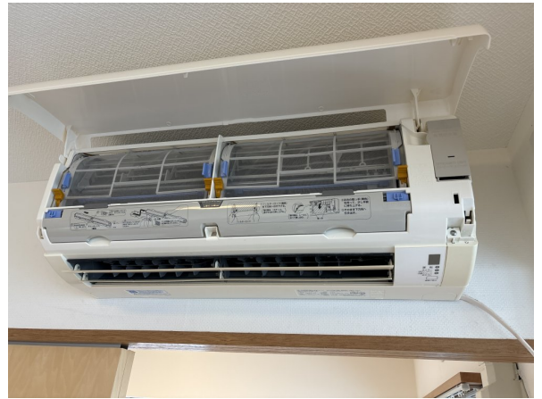
17.エアコンクリーニング
