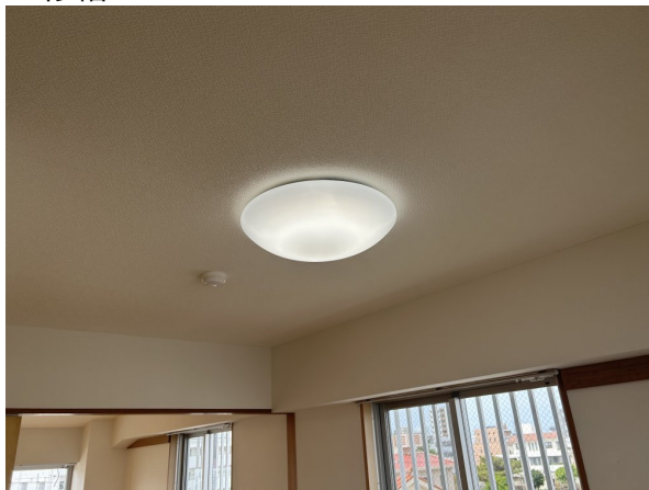
洋間照明取替
