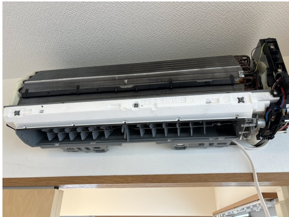
17.エアコンクリーニング
