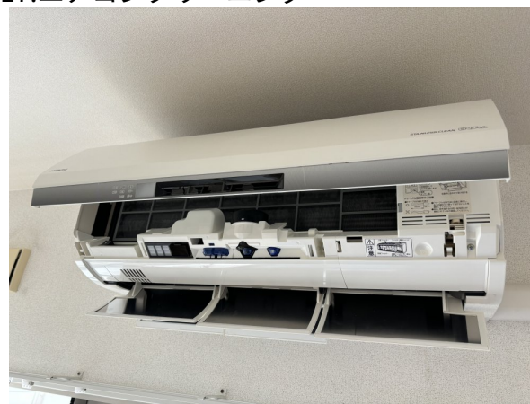
17.エアコンクリーニング
