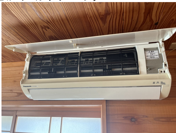
14.エアコンクリーニング
