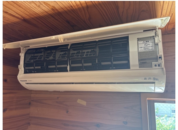
14.エアコンクリーニング
