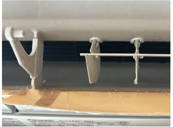
14.エアコンクリーニング
