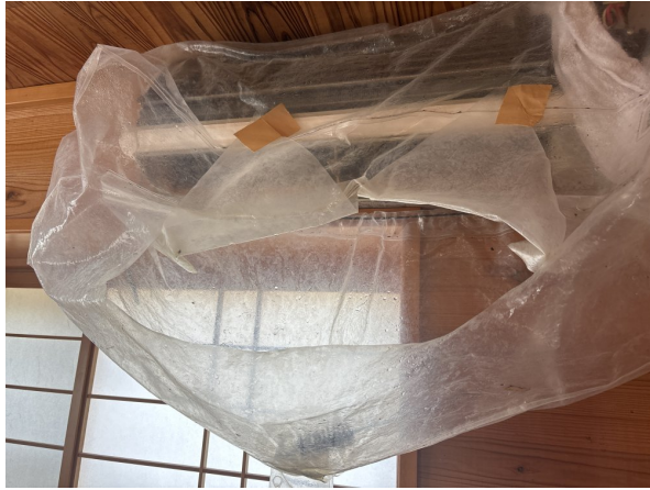
エアコンクリーニング①
