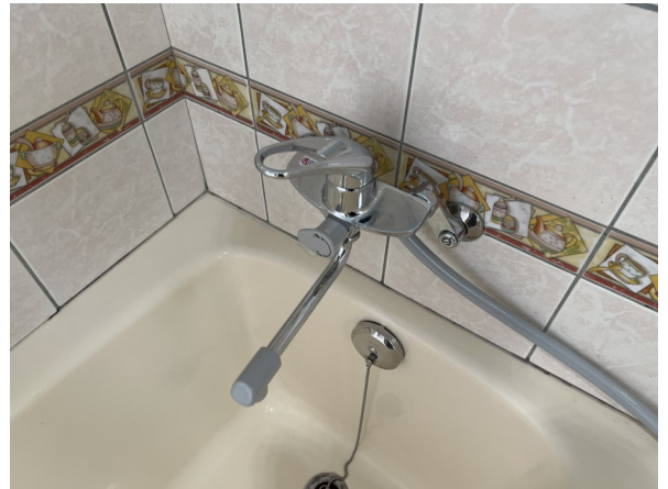
シャワー混合栓取替
