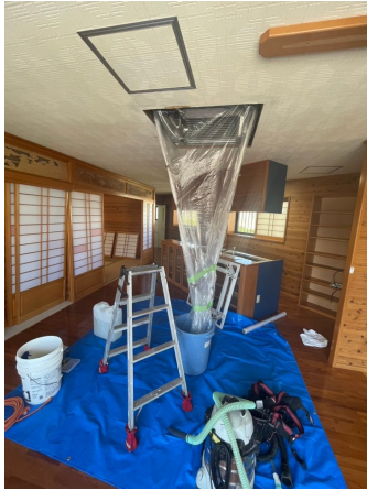
14.エアコンクリーニング
