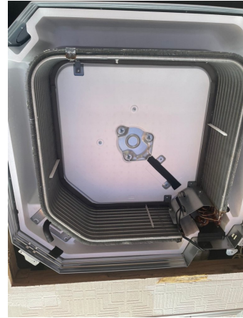
14.エアコンクリーニング
