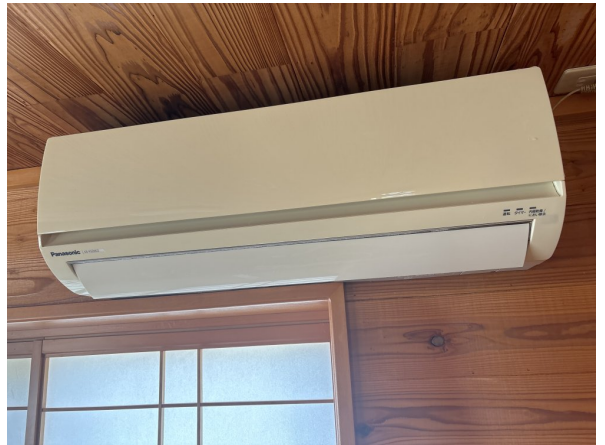
14.エアコンクリーニング
