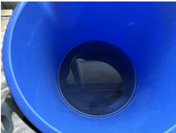
15.エアコンクリーニング
