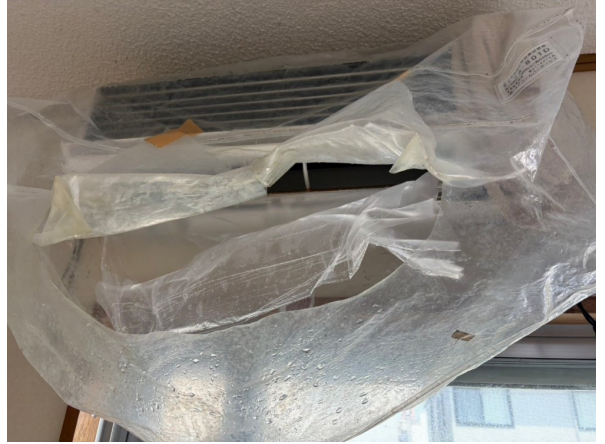
15.エアコンクリーニング
