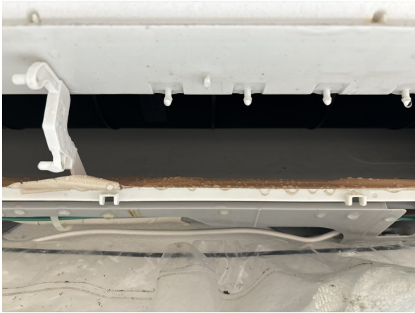
17.エアコンクリーニング
