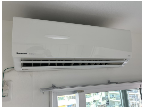
17.エアコンクリーニング
