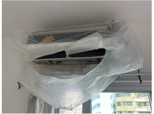
17.エアコンクリーニング
