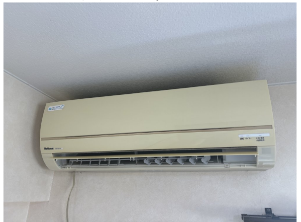
15.エアコンクリーニング
