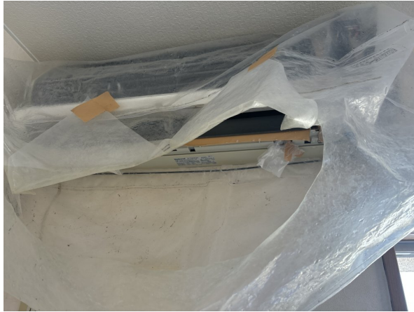
15.エアコンクリーニング
