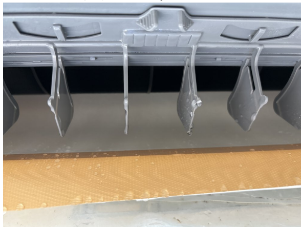
14.エアコンクリーニング
