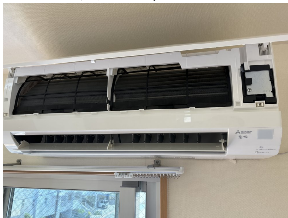
14.エアコンクリーニング
