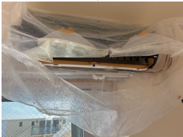
14.エアコンクリーニング
