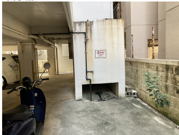
2. 受水槽フェンスまわり
