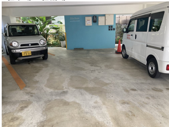
1. 駐車場・駐輪場
