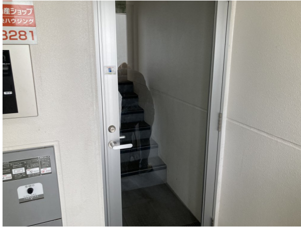
1.エントランスホール（タイル・ガラス）
