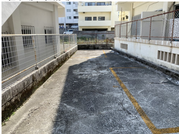
1. 駐車場・駐輪場
