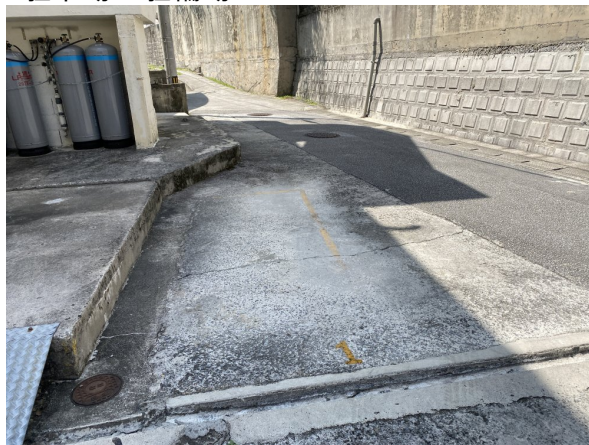
1. 駐車場・駐輪場
