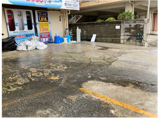
1. 駐車場・駐輪場
