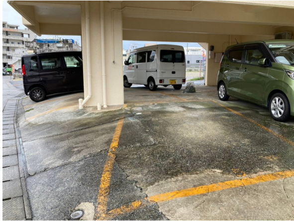
1. 駐車場・駐輪場
