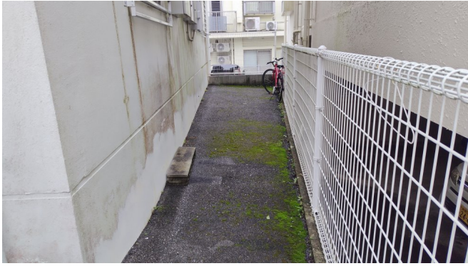
1. 駐車場・駐輪場
