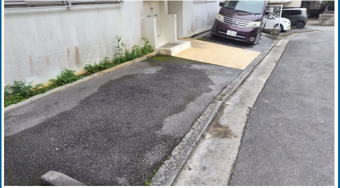
1. 駐車場・駐輪場
