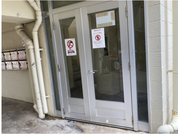
2. エントランスホール (タイル・ガラス)
