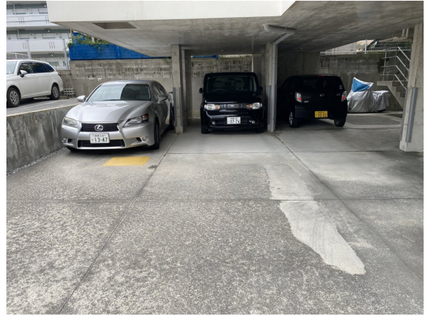
1. 駐車場・駐輪場
