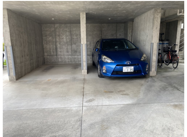
1. 駐車場・駐輪場
