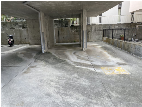
1. 駐車場・駐輪場
