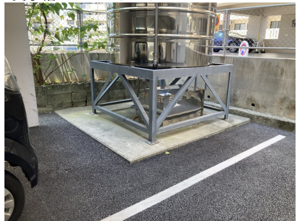
5. 受水槽フェンスまわり
