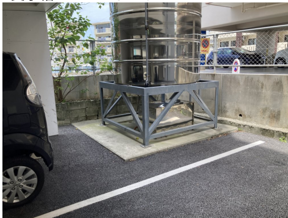
5. 受水槽フェンスまわり
