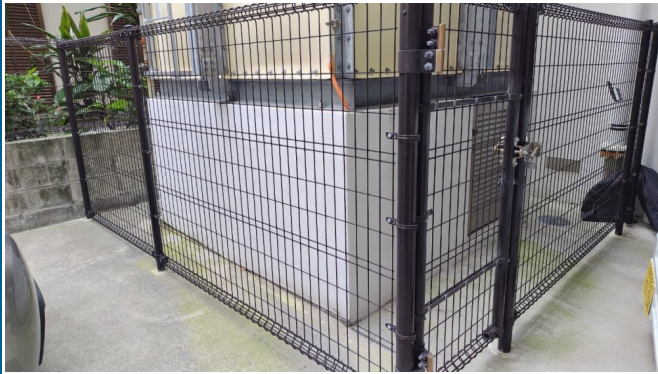
2.受水槽フェンスまわり
