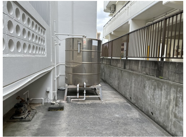
6.受水槽フェンスまわり
