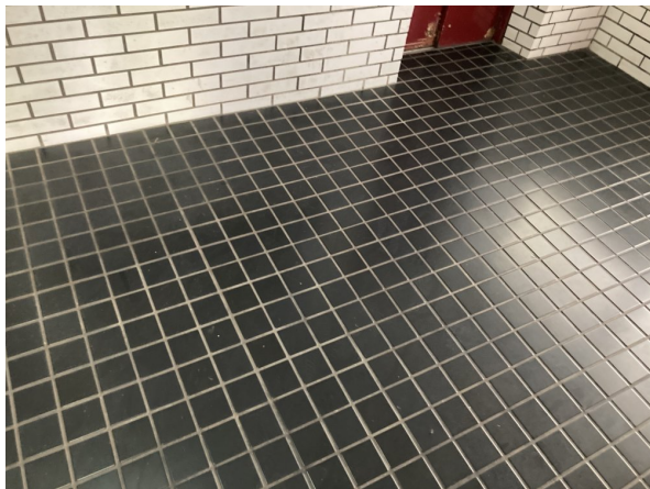
2.EV・ホール
