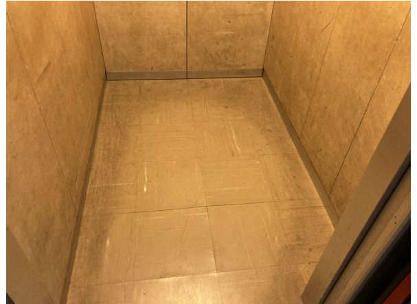
2.EV・ホール
